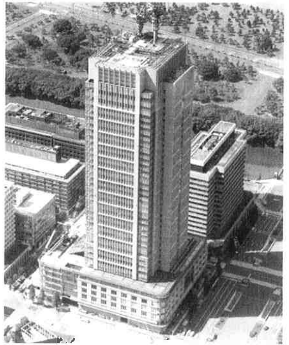
図6.8 新しい丸ビル全景（竣工間近）
