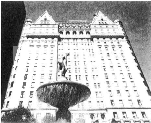
図1.3.4 プラザホテル。フラー社施工のニューヨークの代表的なホテル。1985（昭和60）年、G5でドル高是正を確認した、いわゆる「プラザ合意」はここで行われた
