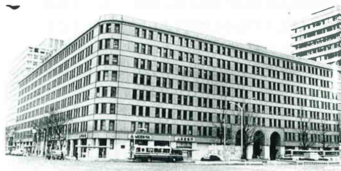
図1.1.2 1985（昭和60）年当時の丸ビル
