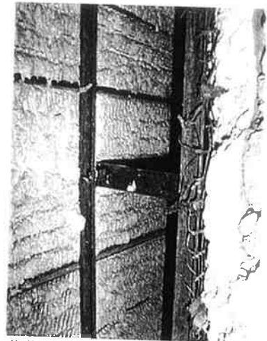
(解体時写真から 8Fエレベーターホール壁下地)
