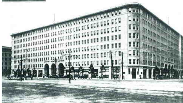
図1.1.1 1923（大正12）年2月20日に開館した当時の丸ビル。 人力車と円タクが玄関脇に並んでいる
