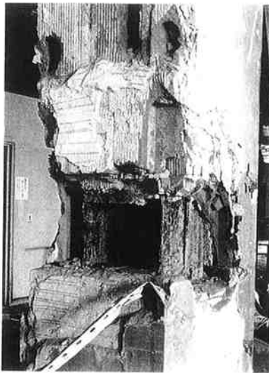
図2.3.1 鉄骨煉瓦造の柱
