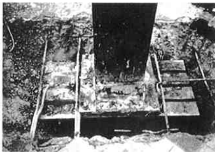
(2) No.48柱脚全体
