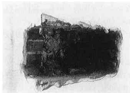
図5.3.7 鉄骨煉瓦造の柱（8階外周柱）
