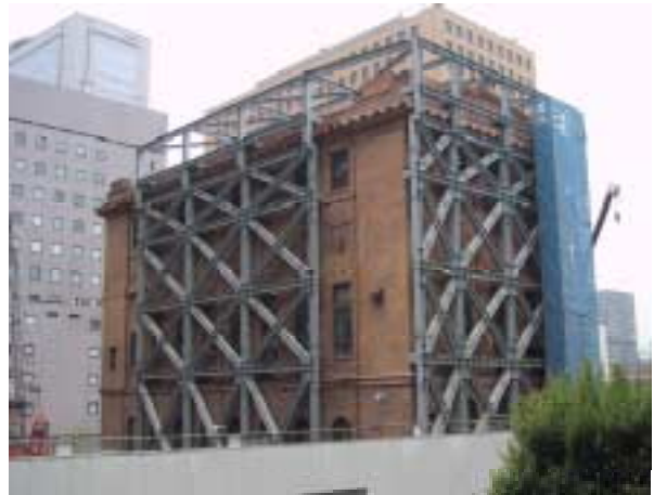
写真 4 1 次仮受け鉄骨梁概況
