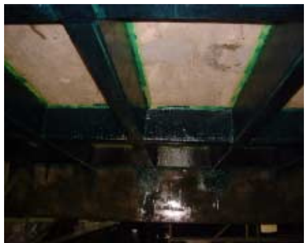
写真 5 炭素繊維シート補強概況
