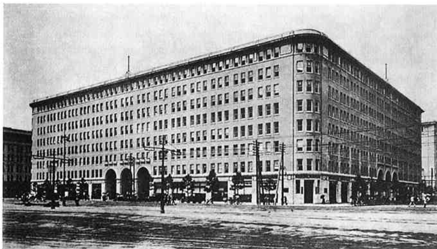
図1.1 竣工直後の旧丸ビルの全景
