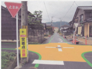
宮津署 新設一時停止、交差点部のカラー舗装化、啓発看板
